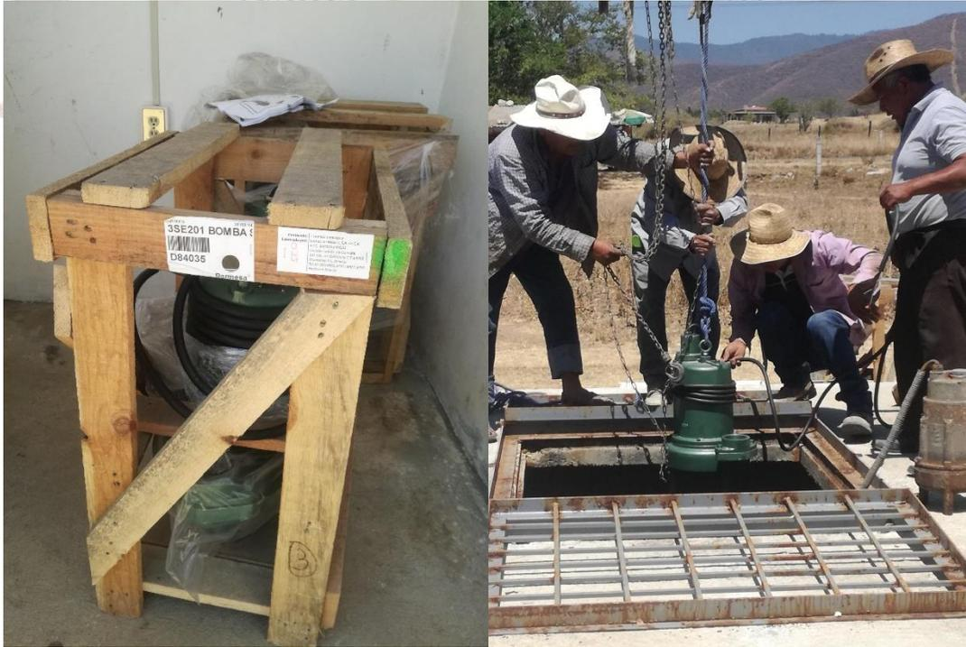
Adquisición de cuatro rejillas de acero inoxidable, para evitar el paso de residuos sólidos y afectar el equipo de bombeo. Así como para sacar los residuos sólidos retenidos.
